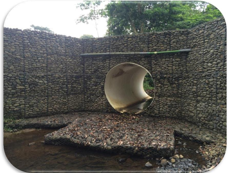
Construcción de paso de alcantarilla Rib-Steel con cabezales de Gaviones en Huetares
