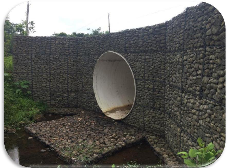
Construcción de paso de alcantarilla Rib-Steel con cabezales sobre Quebrada Manú en el Bambú
